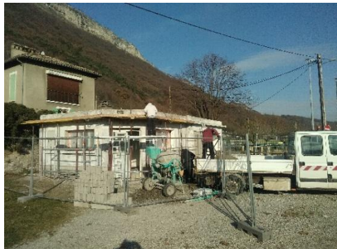
Rénovation complète du bâtiment communal au camping de Vif
